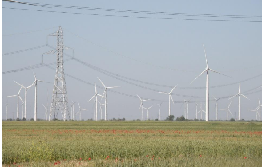
Energía eólica y torretas de conducción de energía eléctrica (La Mudarra, Valladolid)
